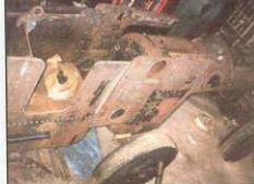
Erste Schritte beim Neuaufbau: Der neue Kessel
